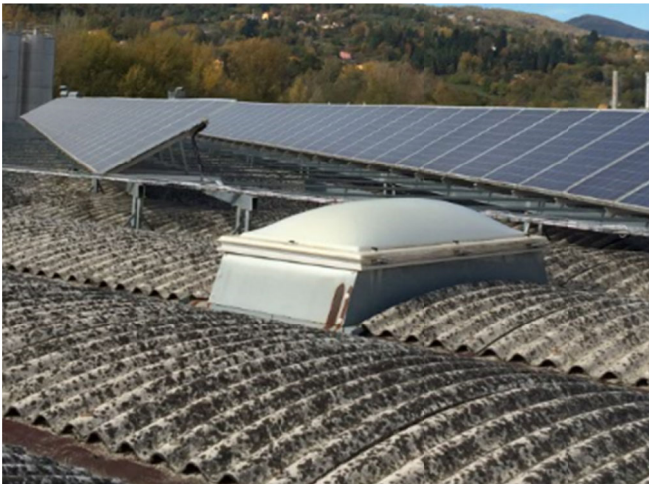
(Foto 2a) EFC non interferenti con l'impianto FV
