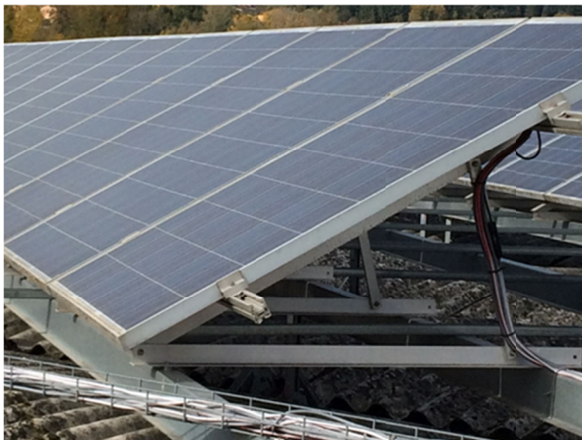
(Foto 1) - Installazione pannelli fotovoltaici su struttura metallica
