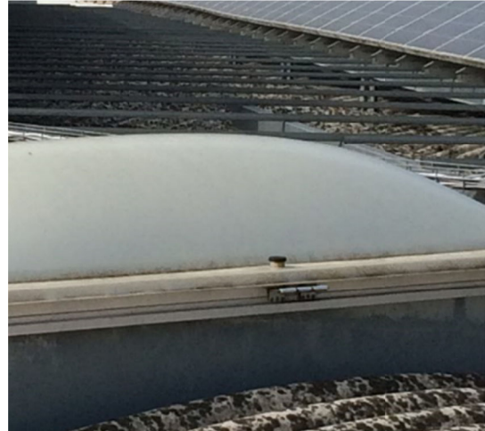
(Foto 2b) Particolare EFC
