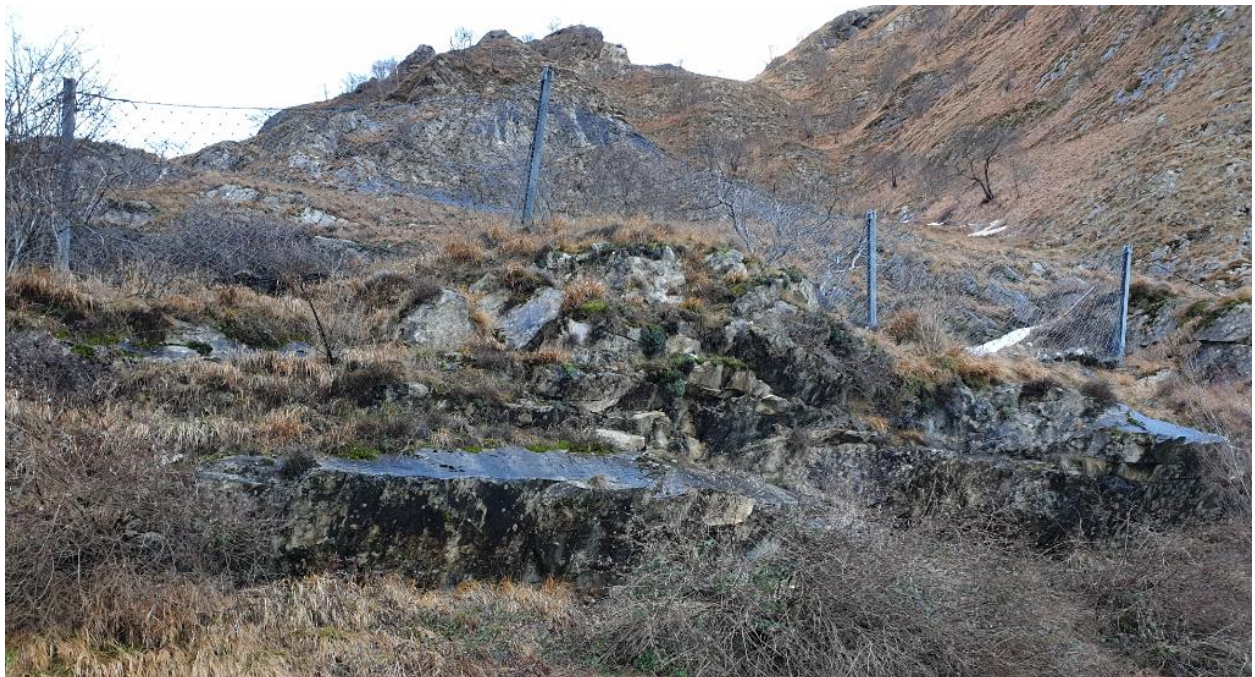
Opere esistenti di protezione a monte del piazzale di ingresso dell'Antro
