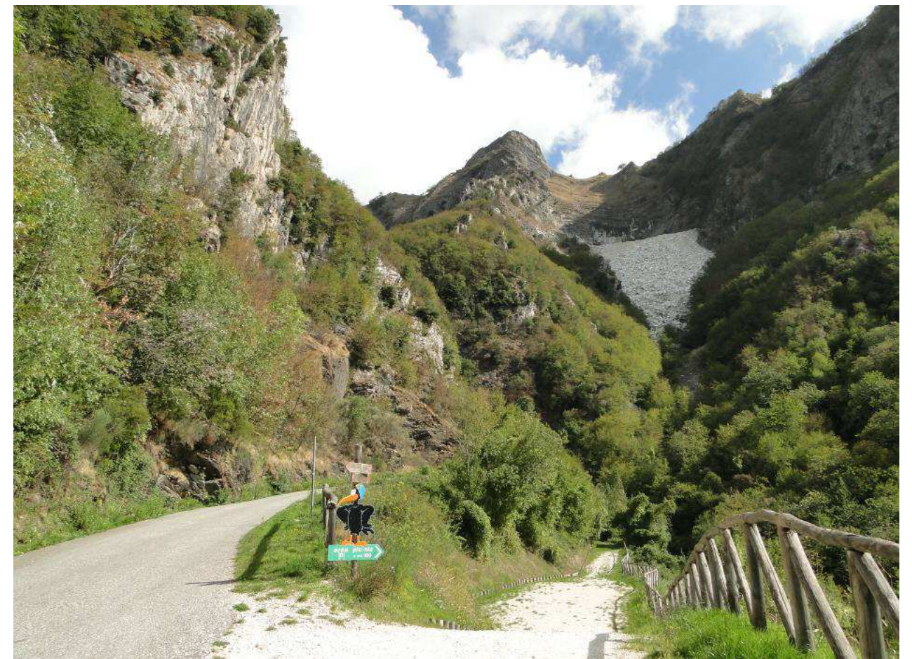
14 - Strada di accesso Antro del Corchia - Bacino Borra larga
