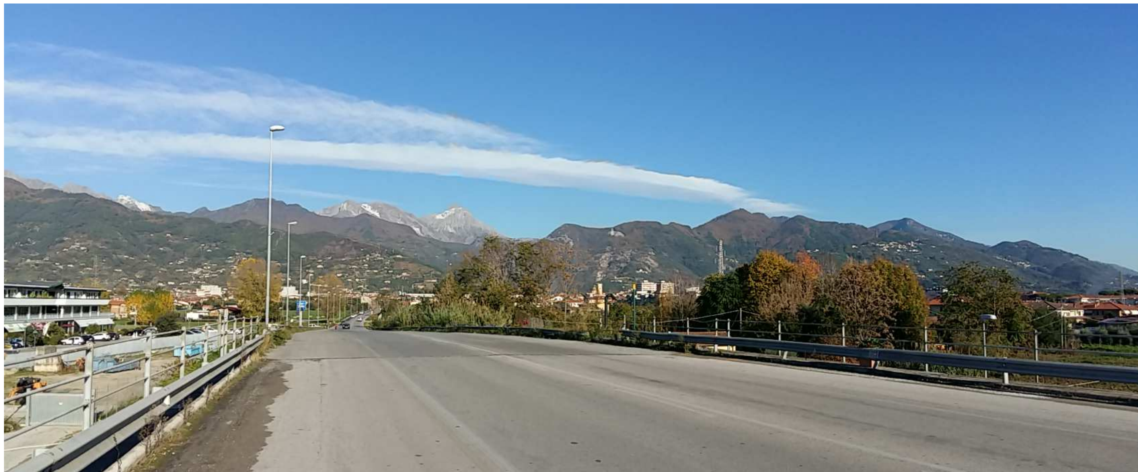
4 - Panoramica dal cavalcavia di Via Alpi Apuane - S.P.9 (Querceta) – Bacino Monte Corchia e Borra Larga
